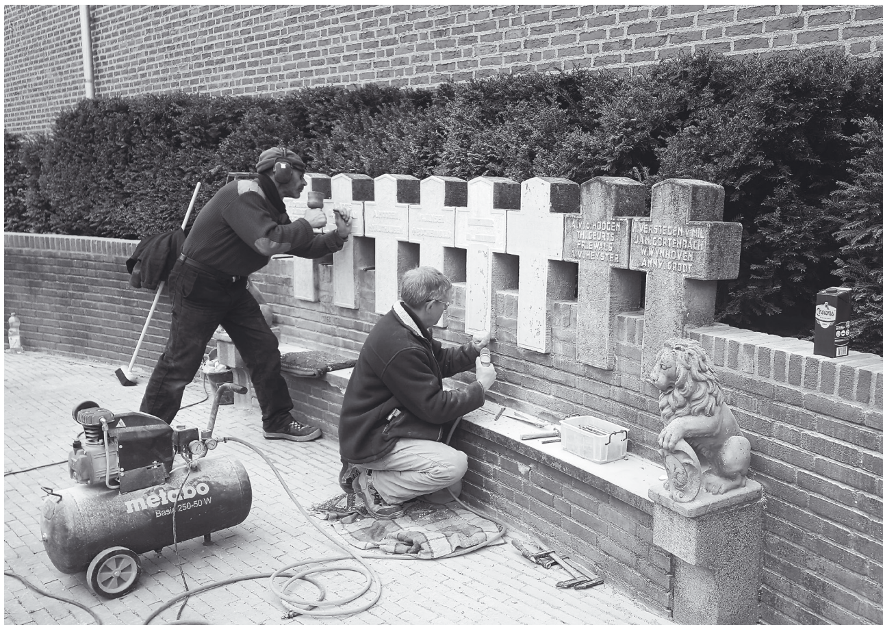
Een bijzonder gezicht, 2 vakmensen zijn deze week hard aan het werk met de renovatie van de kruizen van het oorlogsmonument bij de kerk. De letters en randjes worden opnieuw uitgekapt!
